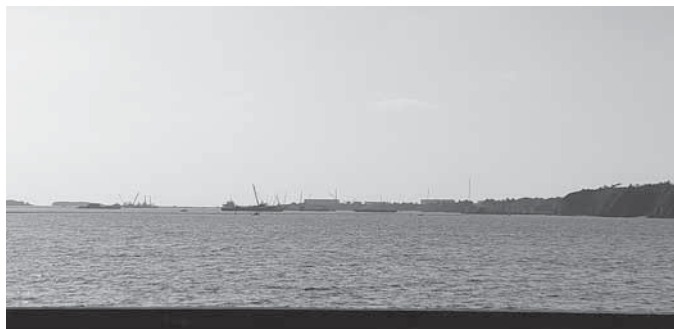
◆目前に建設現場が迫る
