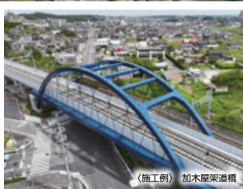
〈施工例〉加木屋架道橋
