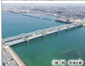
〈施工例〉衣浦大橋
