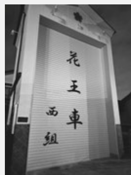
手書きで仕上げた山車蔵シャッター
